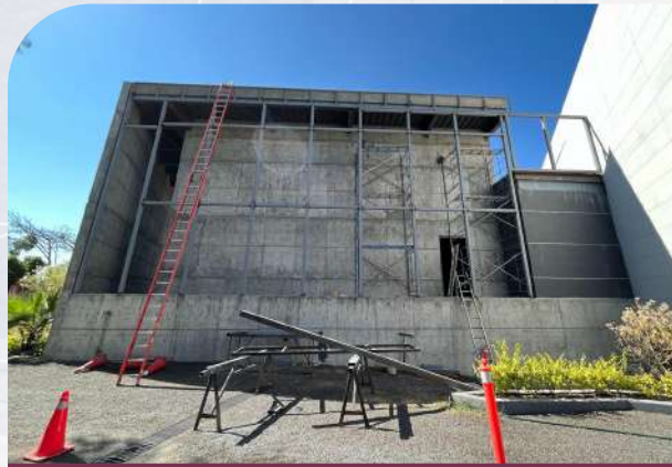
Trabajos en la fachada interna para protección del inmueble.
