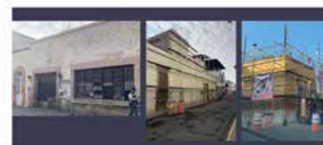
Pueden verse las modificaciones de interiores, pedidos en el centro histórico de Aguascalientes, las intervenciones buscan a generar espacios en un segundo o tercer piso con vistas a la zona. En algunos casos el mobiliario arquitectónico es mucho más moderno y se integran que también espacios de ambiente comercial, área de eventos, que posteriormente lleguen a ser de hospedaje colaborativo. Fotografías: molten 2021.
